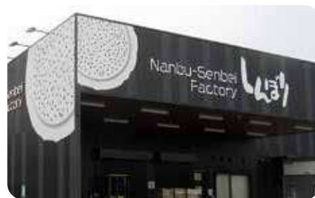
製造ラインを強化するため、5年2月に第二工場の稼働が始まりました
