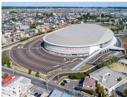
長根屋内スケート場
