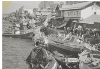
新井田川右岸に打ち上げられた漁船 (チリ地震津波)
