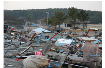
白浜海水浴場の被害状況 (東日本大震災)
