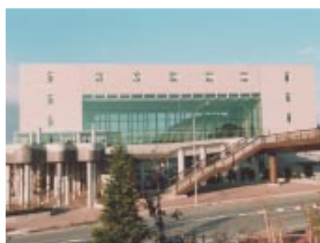
(東奥日報社八戸ビル)
