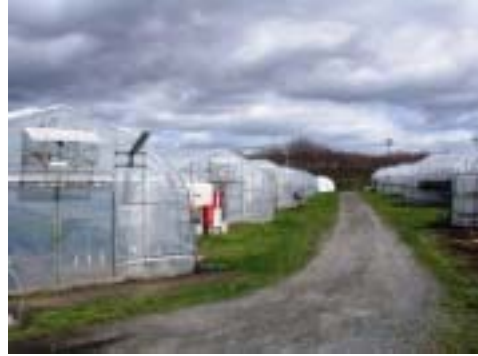
パイプハウス外観
