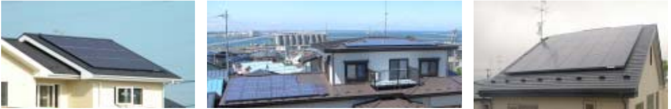
市内の住宅用太陽光発電システム設置状況
