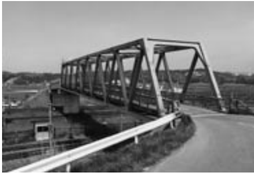
八戸通り跨線橋
