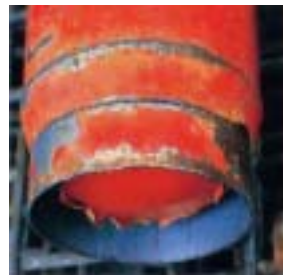
サビを落としても 腐食の残るもの
