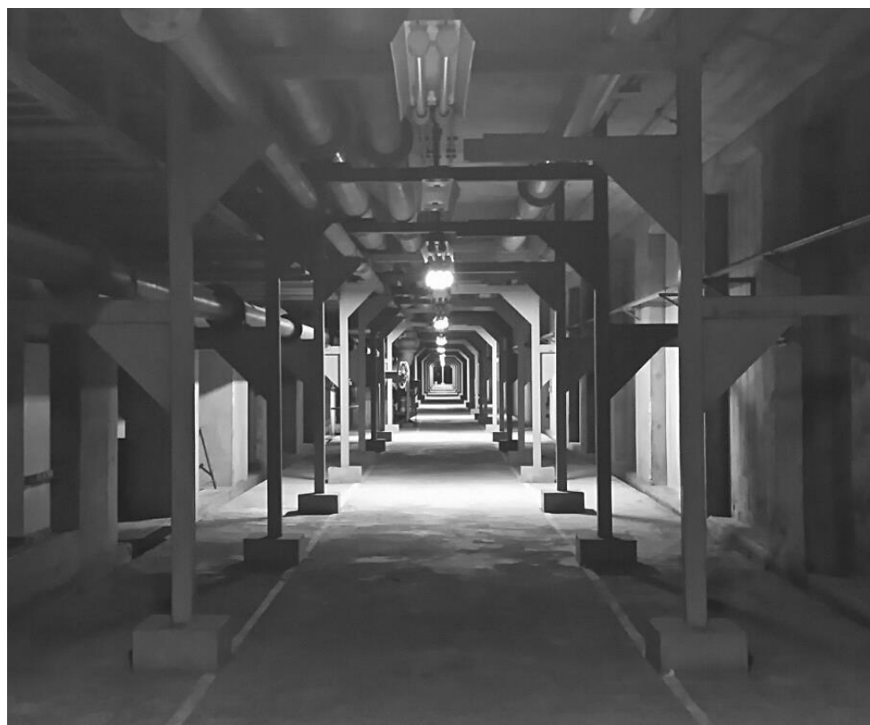
八戸市東部終末処理場 水処理中央管廊
